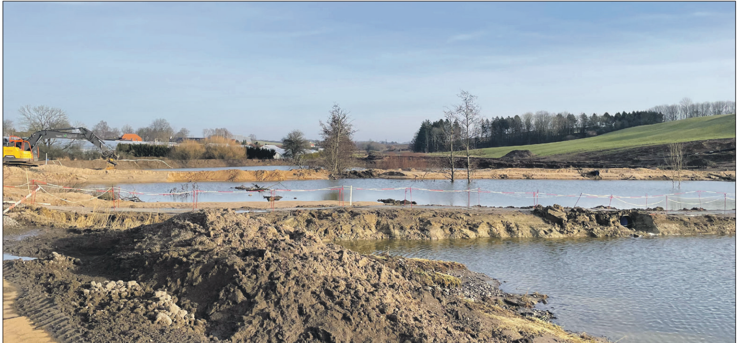
Ved Nordic Waste er der etableret flere regnvands- og opbevaringsbassiner til forurenede overfladevand
